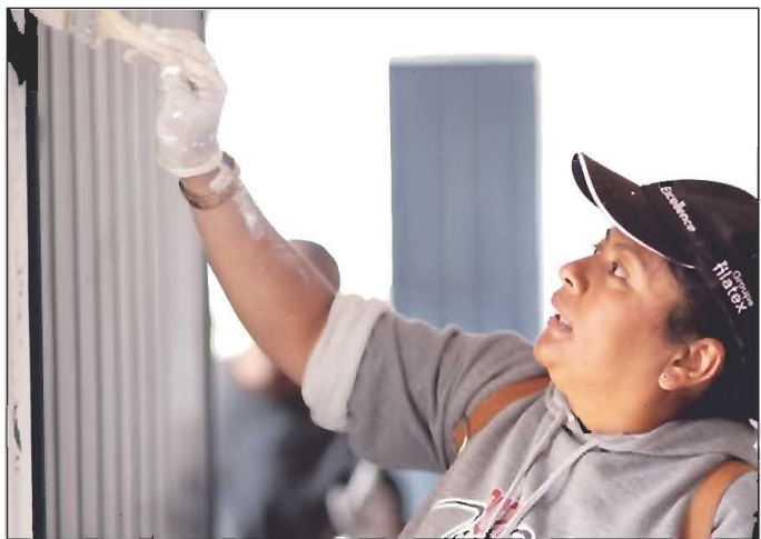
Les travaux ont été menés afin d'offrir un environnement d'apprentissage plus sain et plus confortable aux élèves.
